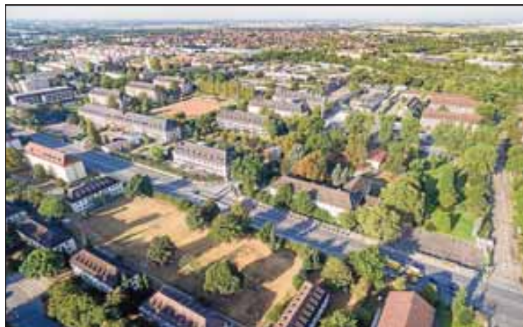
Ein Blick von Nordosten über die Römerstraße auf die Campbell Barracks. Auf dem Areal sollen sich vor allem Unternehmen ansiedeln. Foto: Buck
