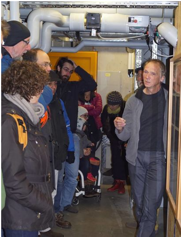
Günter Bergmann (r.) erläutert im Keller das Energiekonzept mit Solarthermie- und Photovoltaikanlage sowie einer Latentspeicherheizung.
