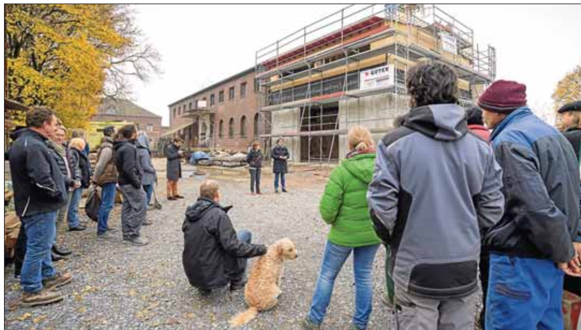
Der Verein „Werkstattschule“ feierte Richtfest im Bahnbetriebswerk beim Ochsenkopf. Im neuen Anbau werden Büros entstehen, die das bereits bestehende Atelier ergänzen. Foto: Philipp Rothe
