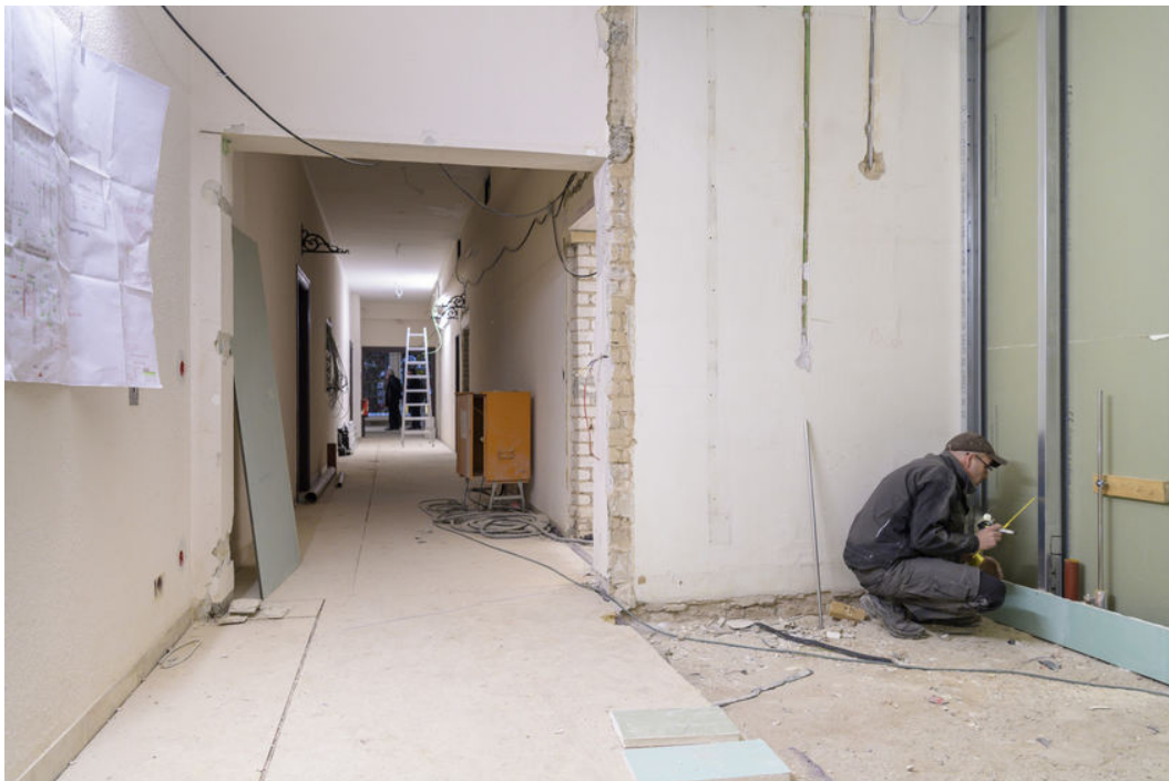
So sind etwa die Marmorböden, mit denen das Gebäude ausgelegt ist, während der Bauarbeiten durch Holzplatten verdeckt. © Philipp Rothe
