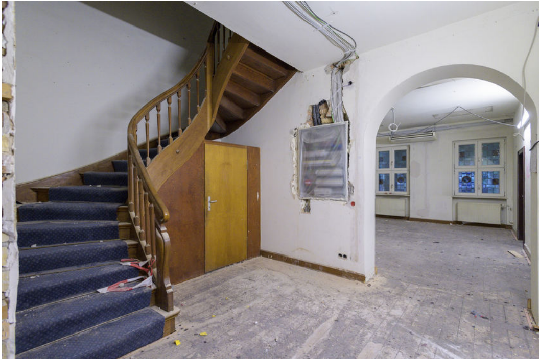
In den meisten Räumen ist es auch noch dunkel, da die komplette Elektrik ausgetauscht werden muss. © Philipp Rothe
