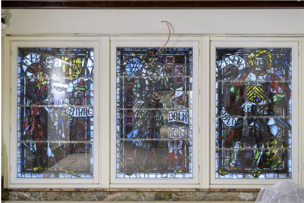
Noch dominieren die Bauarbeiten die ehemalige Kommandantur, die zum Mark Twain Center wird. © Philipp Rothe
