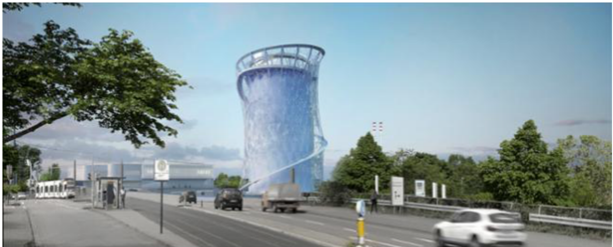
Energie- und Zukunftsspeicher; IBA Internationale Bauausstellung Heidelberg 2018 (Foto/Copyright: Lava)
