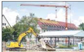
Hinter dem alten Checkpoint wird das Gebäude der Wohngruppe „Hagebutze“ saniert.
