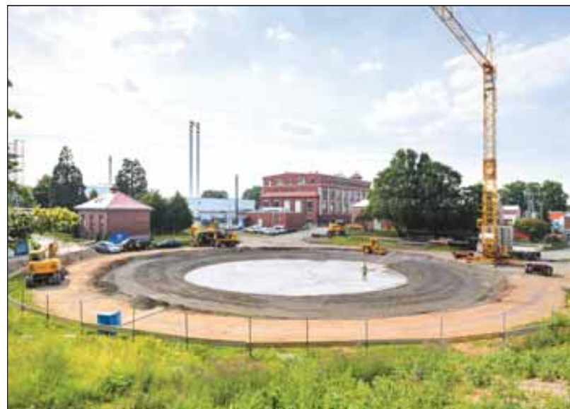
Das runde Fundament zeigt die Ausmaße des Energie- und Zukunftsspeichers der Stadtwerke im Pfaffengrund. Auf dem Dach der „überdimensionalen Thermoskanne“ sind ein Restaurant, eine Energie-Erlebniswelt und eine Aussichtsplattform geplant. Foto/Illustration: Rothe/Stadtwerke
