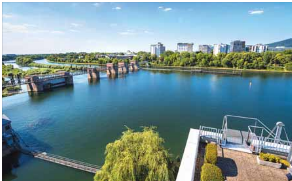
Das Wehr Wieblingen zwischen Bergheim und Neuenheim soll neu gebaut werden – wann, ist allerdings offen. Deshalb will die Stadt östlich des Wehrsteges eine neue Brücke für Fahrradfahrer und Fußgänger bauen. Foto: Rothe
